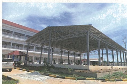
建設の進む体育館
