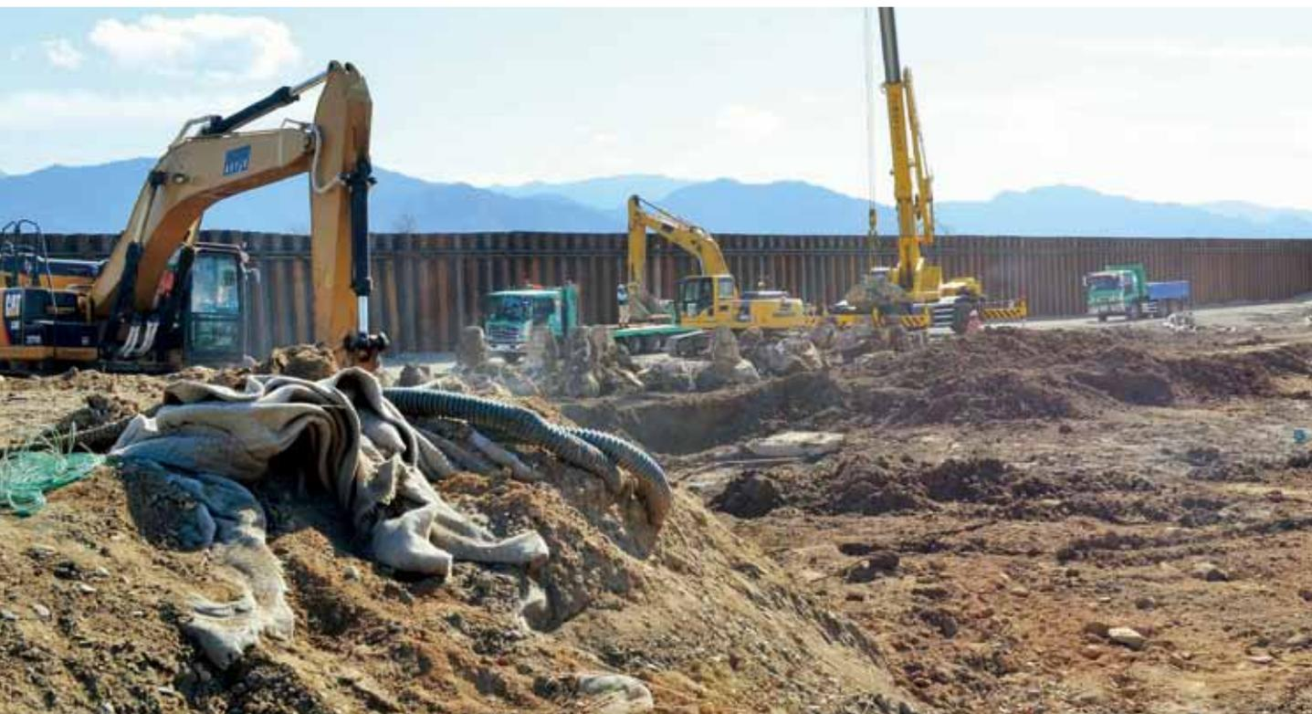
千曲川の堤防の決壊現場では、復旧工事が続いています。奥に見えるのは被災後に設置した仮堤防。
