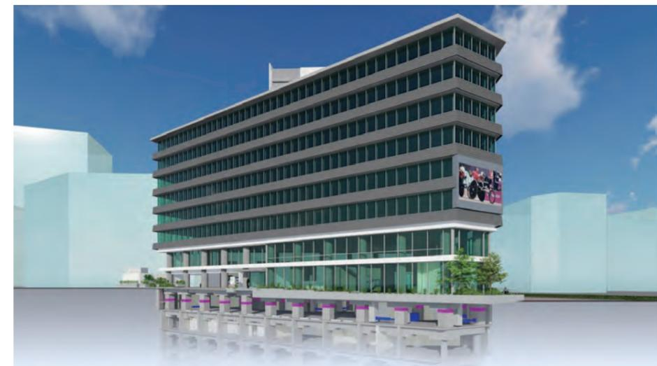
建物を使いながら地下1階柱頭免震工法にて改修工事を実施
