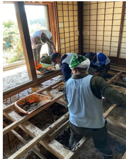
床下泥出しの様子
