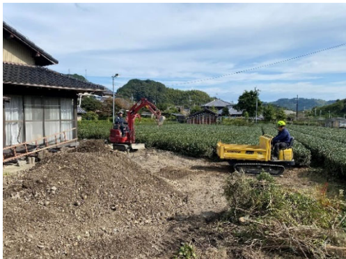
重機による泥出しの様子
