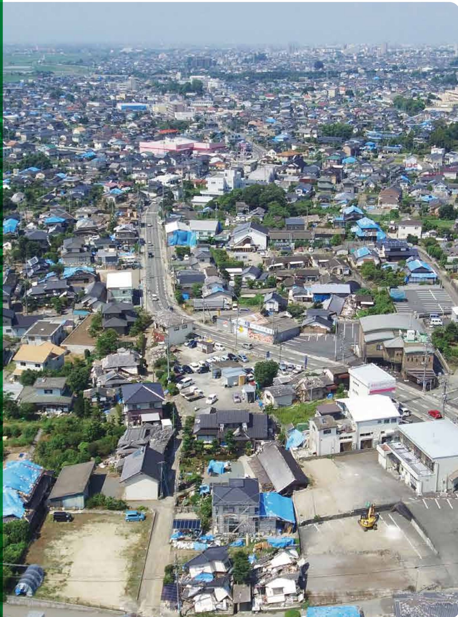
ドローンで撮影された震災直後ブルーシートで覆われた益城町の被害家屋(公益社団法人みらいサポート石巻提供)
