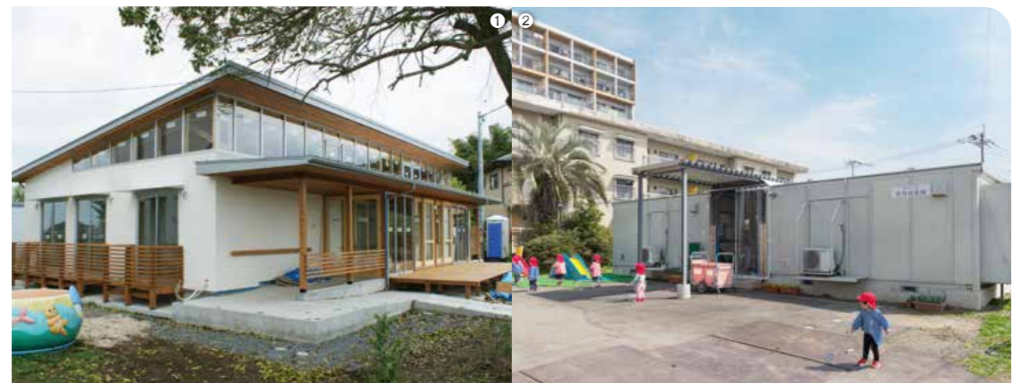
①第二明星学園仮設住宅(建設中) ②聖母幼愛園 仮園舎
