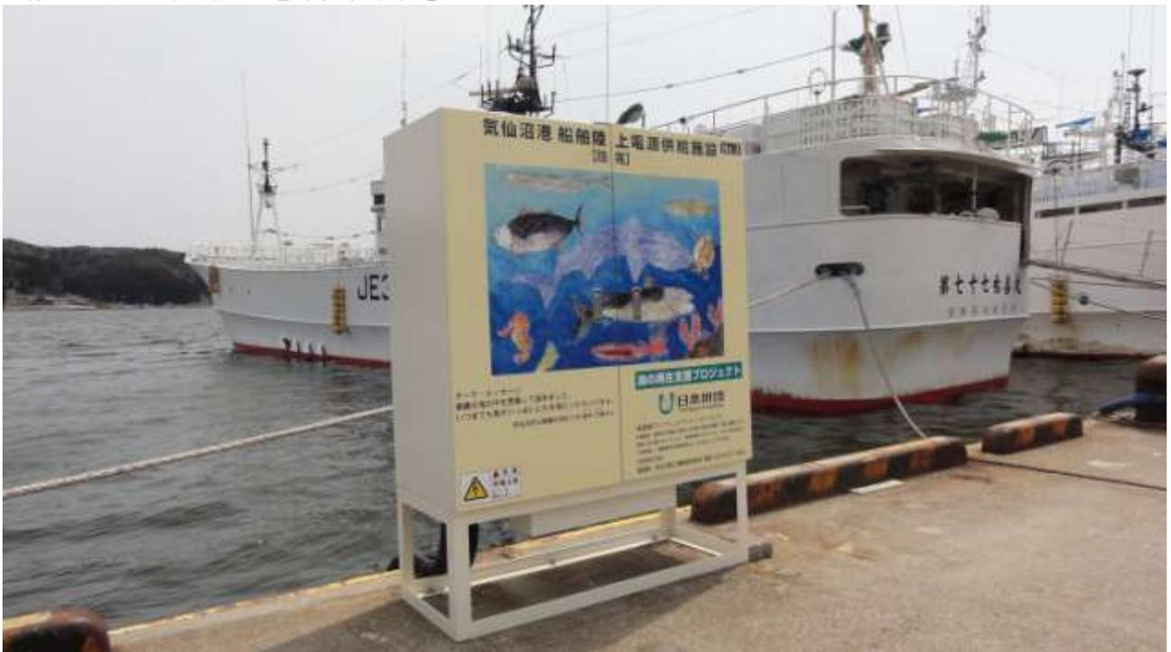
※船舶陸上電源供給施設とは、電力会社から受電した電力を補給・整備、荒天時の避難、乗組員の休暇などの目的のため停泊している漁船に供給する設備。
