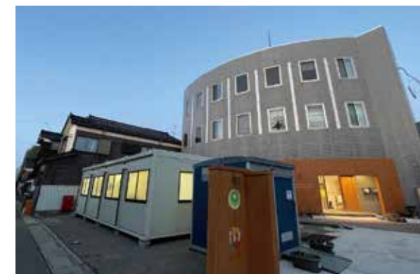
入口の自動扉が壊れ開放状態となっているわじまティーンラボの入る建物 トイレが使用できないため、敷地内に仮設トイレを設置
