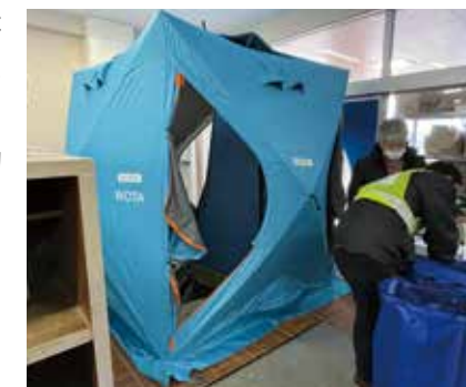
水を再生・循環利用することで、水道がなくても利用できるシャワー装置の設置
