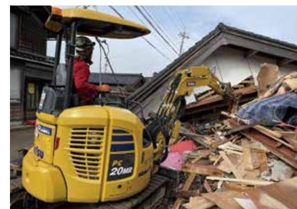
石川県珠洲市（能登半島地震）重機を用いた貴重品の搜索活動
