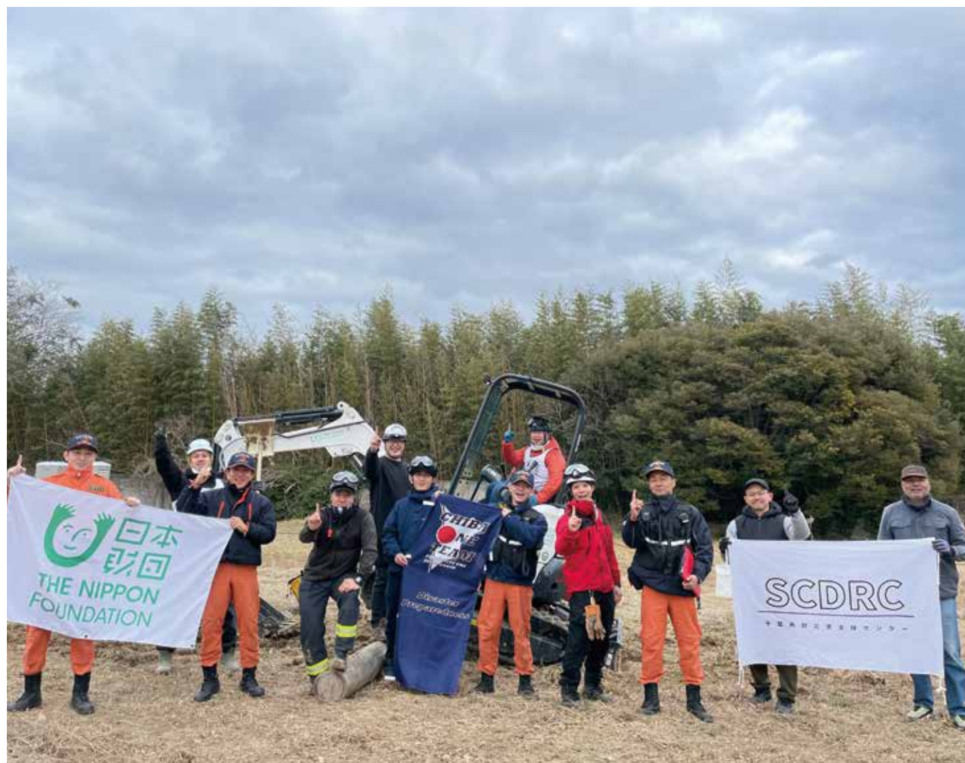
災害対策拠点プロジェクト／重機練習会／千葉県木更津市
