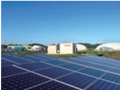
太陽光発電施設と植物工場
