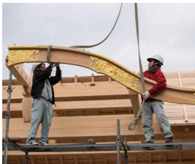
福岡県の工房で唐破風の屋根など舞台の仮組みが行われた
