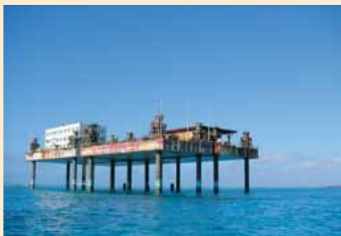
気象・海象観測などが行われている観測施設
