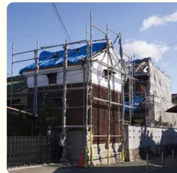
ブルーシートで屋根の応急処置
