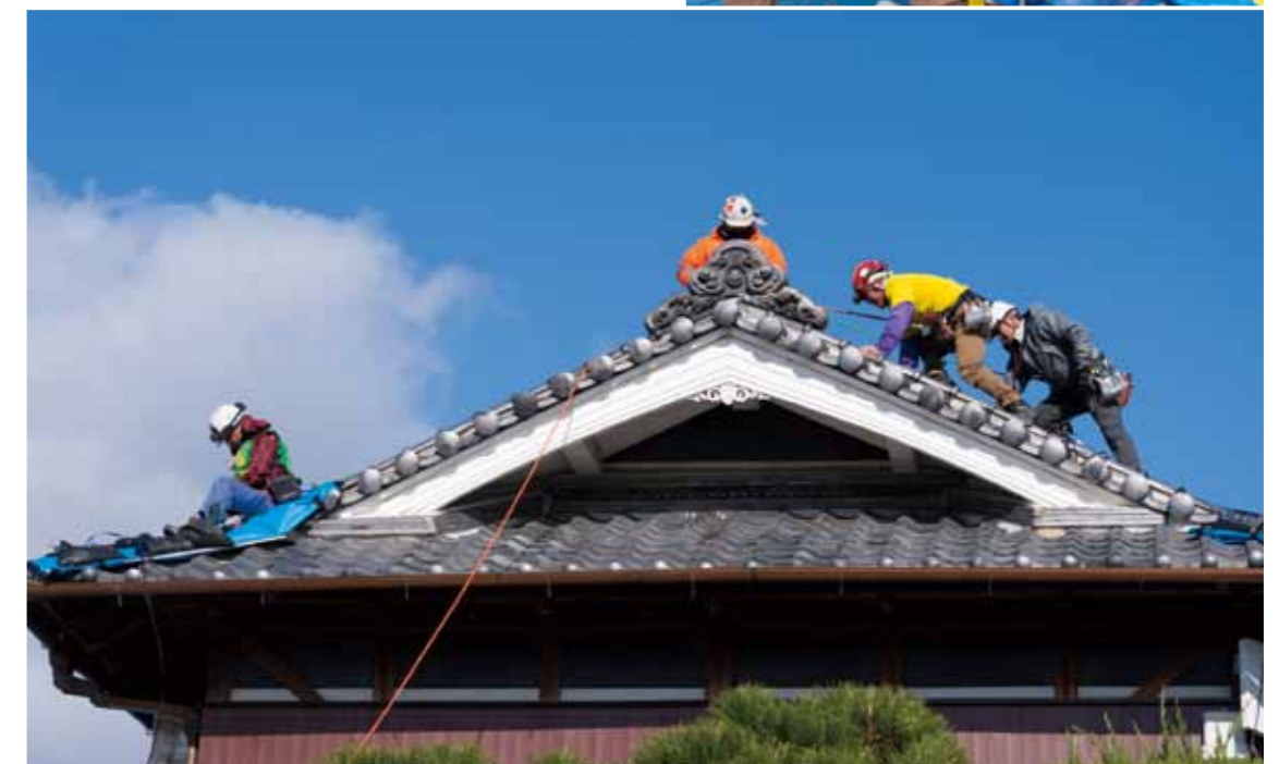
[上]ブルーシートを屋根に張る作業を説明するレスキューアシストの中島さん。 [下]作業は危険を伴うので、専門の知識や安全対策をしながらの作業。
