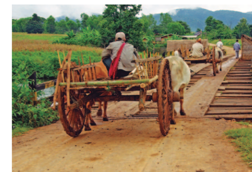
雨季には橋が壊れて村が孤立することも[ミャンマー、2011年9月]
