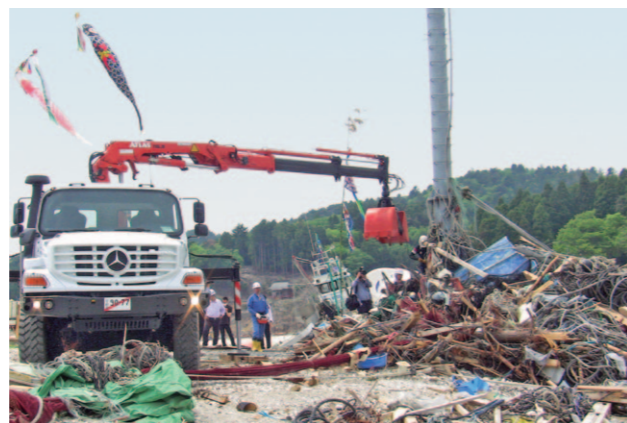
足場の悪い海岸で、がれきの処理に威力を発揮したゼトロス(宮城県石巻市、2011年5月)
