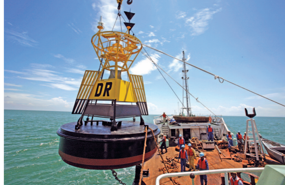
大型船舶の航行安全に欠かせないブイ(浮標)の設置・維持・管理に支援(マ・シ海峡インドネシア領内のドリアンストレットのブイ)
