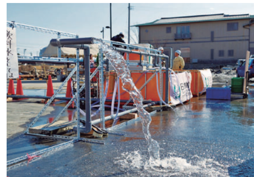
住民に、自由に使える水を提供した浄水プラント[宮城県石巻市、2011年3月]
